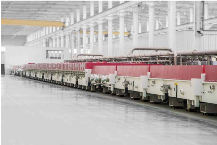
Bildtext: Beschichtungsanlage von NorthGlass mit einer Länge von 270 m für die Beschichtung von 18 m langen Glasscheiben. (Quelle: © NorthGlass)
